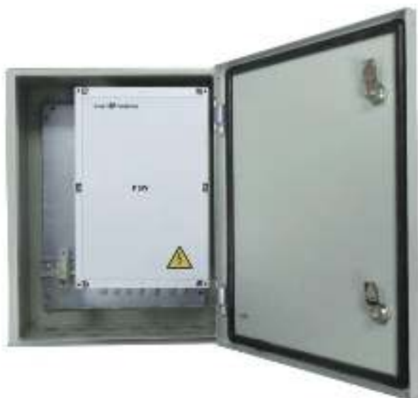
Рисунок 7.3 - Монтаж коммутатора в уличном шкафу.
