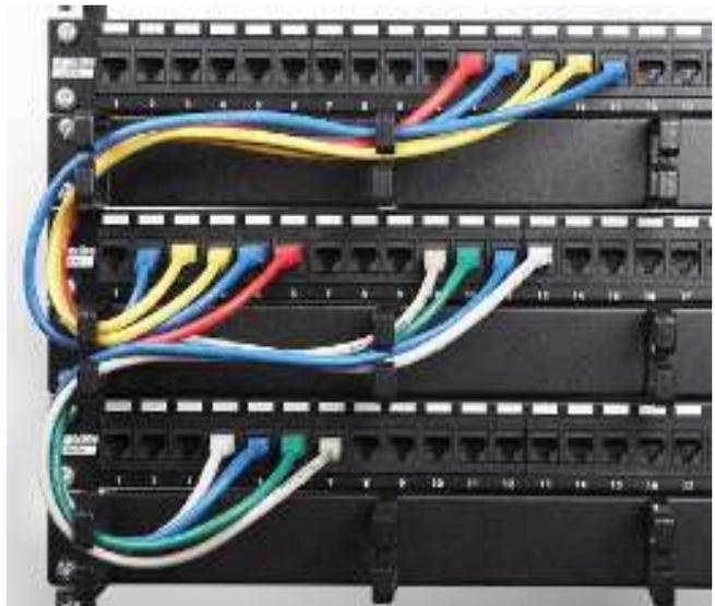
Пример установки горизонтальных кабельных организаторов с пластиковыми кольцами.
