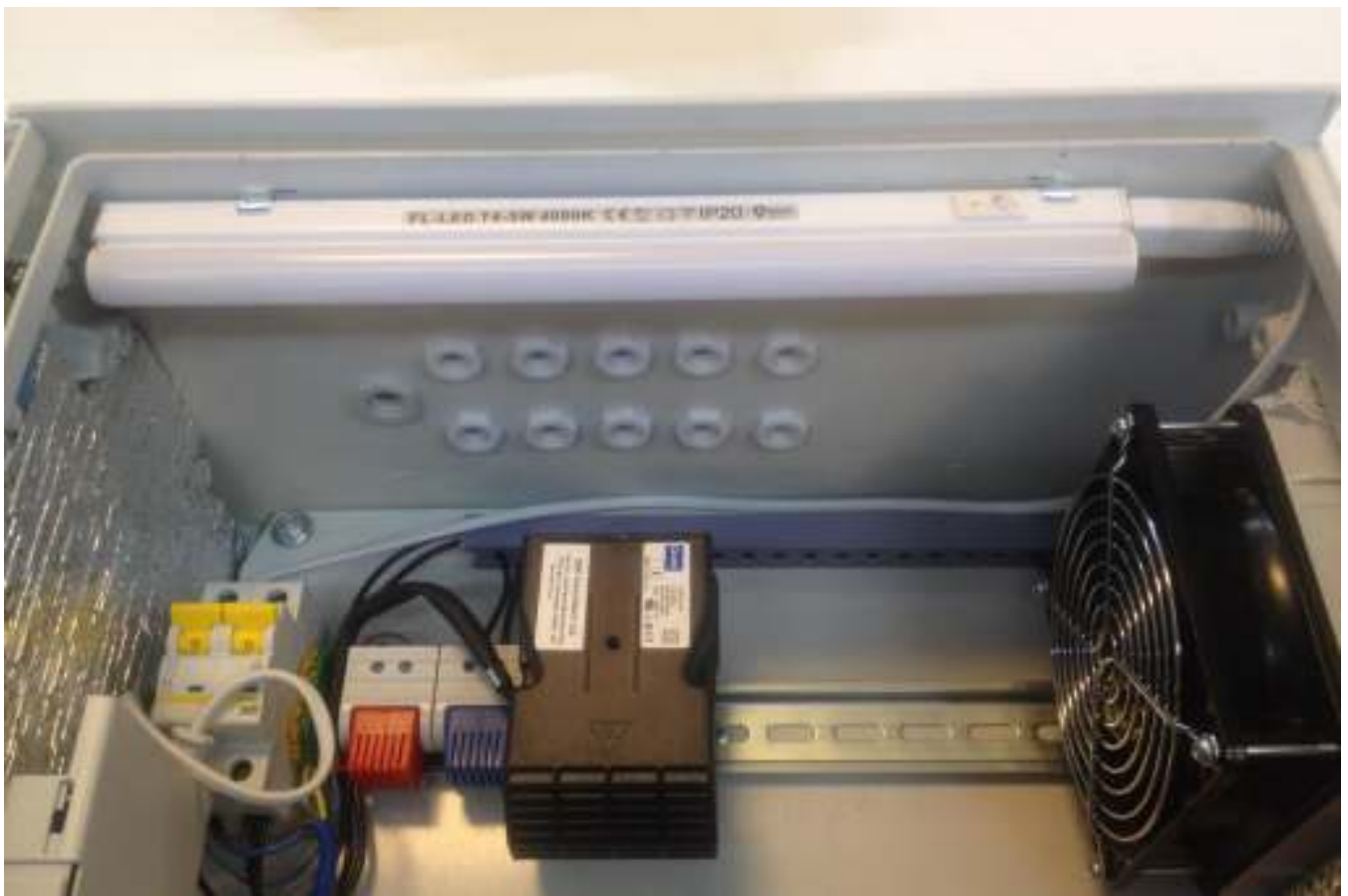
Рис.3.1.3-1 Светильник установленный в пружинные крепления шкафа OSP.
