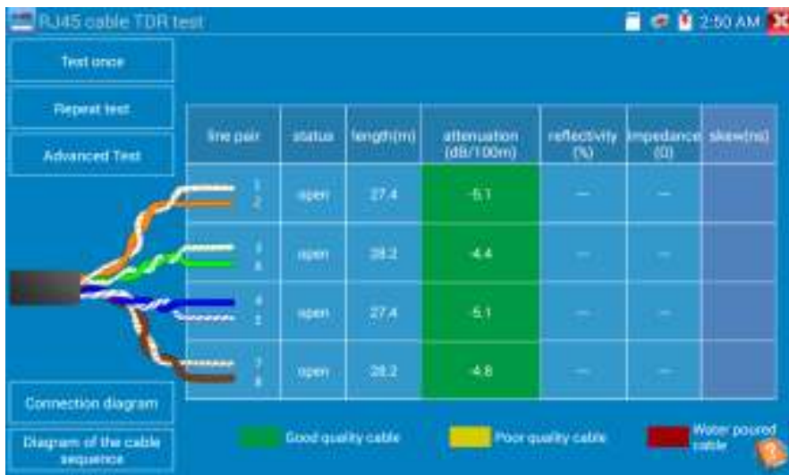
Рис. 101 Детальный тест кабеля (Advanced test)
