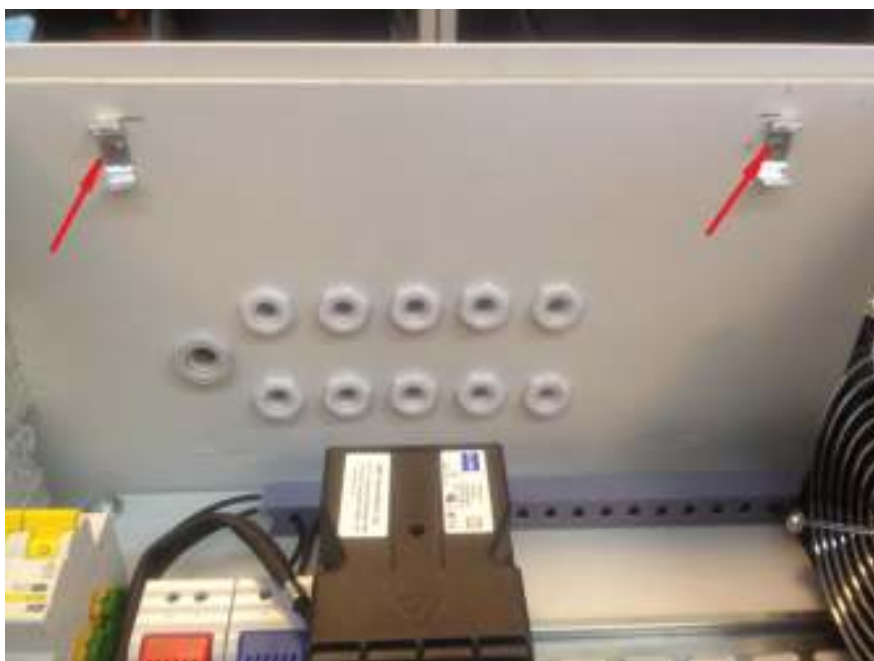
Рис.3.2.2-1 Установка пружинных креплений шкафа OSP.
