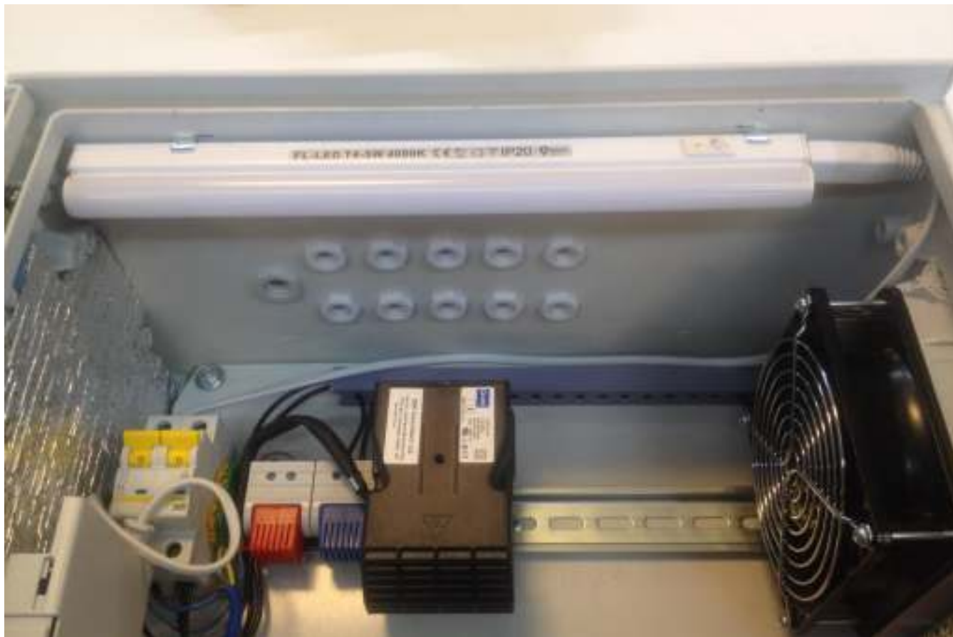
Рис.3.2.3-1 Светильник установленный в пружинные крепления шкафа OSP.
