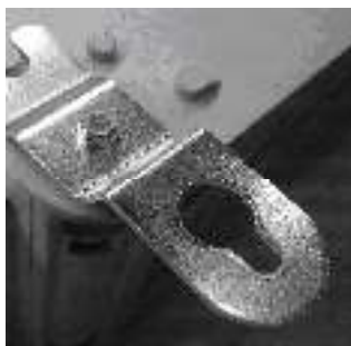
Рисунок 4 – установка проушин
