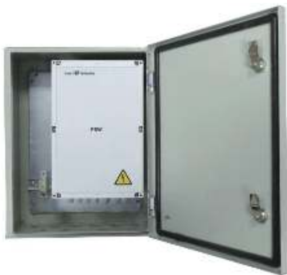
Рисунок 7.3 - Монтаж коммутатора в уличном шкафу.
