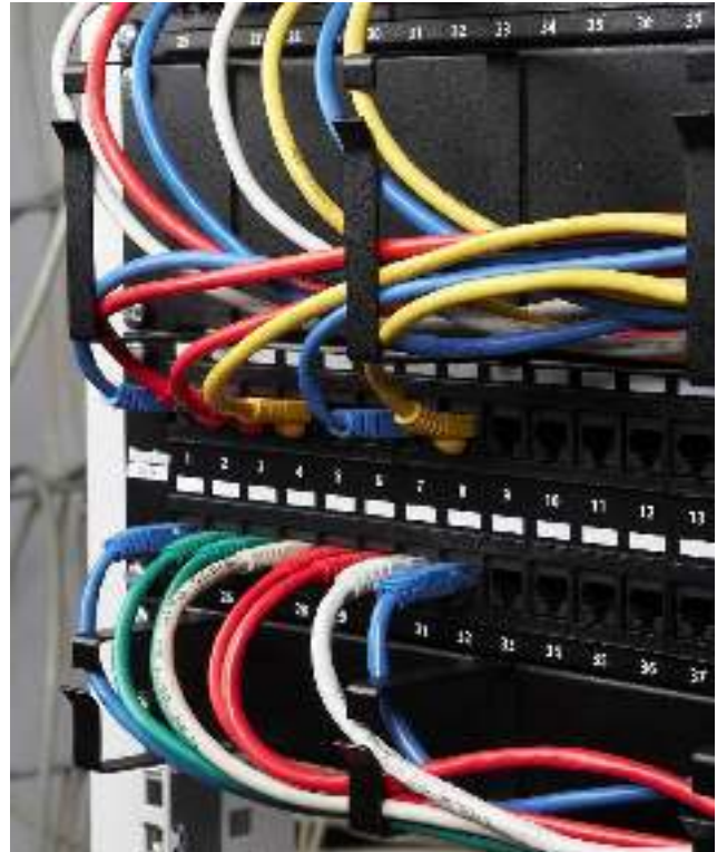
Пример установки кабельных организаторов с металлическими кольцами.
