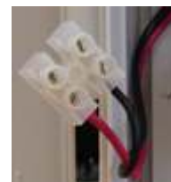
Рисунок 10. Клеммы для подключения замка к блоку питания
