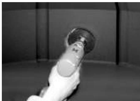
Рис. 10 Сверление отверстия для установки ЗПТ
