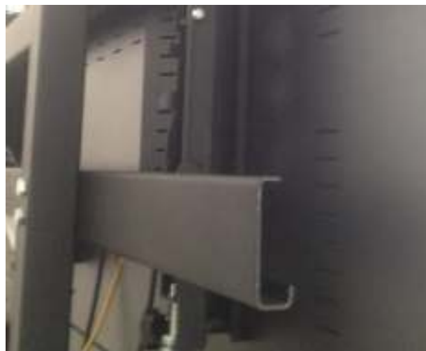
Рис.3 Нижняя горизонтальная направляющая
