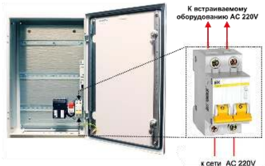
Рис.4 Точка подключения уличной станции к сети 220V переменного тока на примере модели OS-46T1
