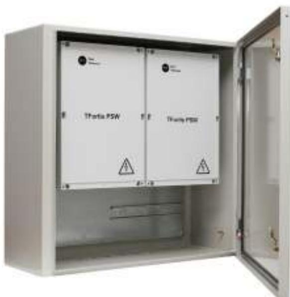
Рисунок 2.1.2 - Вид внутри шкафа с коммутаторами TFortis PSW
