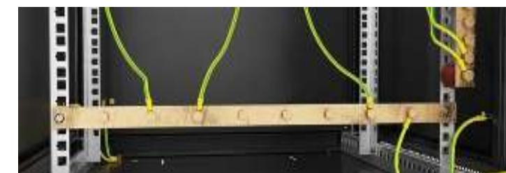
Заземляющая шина подключается к одной из шпилек заземления. К установленной шине необходимо подключить внешний заземлитель, а также все установленное оборудование. Для каждой единицы оборудования должен использоваться отдельный заземляющий провод.
