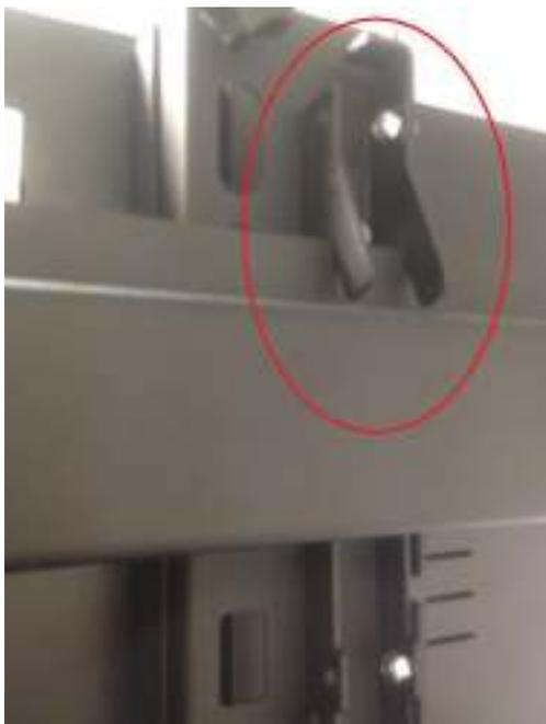
Рис.7 Навеска панели на верхнюю горизонтальную направляющую.
