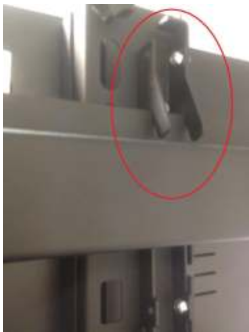
Рис.7 Навеска панели на верхнюю горизонтальную направляющую.
